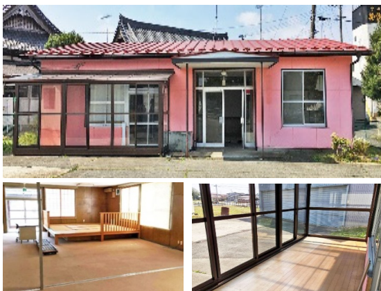
△共同生活を行うプロジェクトの拠点施設
