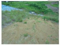
図 5.1 主な遺構の分布範囲における洗掘対策箇所と盛土流出状況
