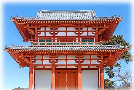
★復元整備中の外郭南門★
