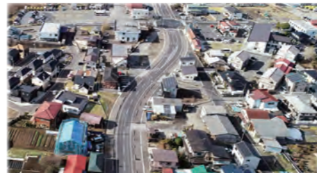
整備した都市計画道路一迫南線(築館)
