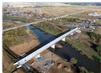
整備が進む(仮称)栗原東大橋
