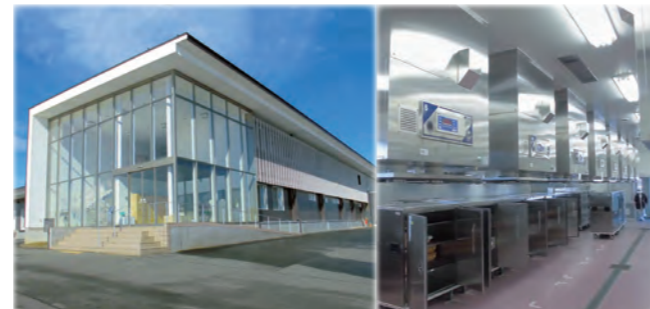
改修した南部学校給食センター
