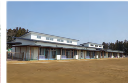
整備した瀬峰幼稚園・保育所・子育て支援センター
