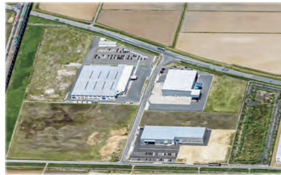
平成28年に分譲開始した若柳金成インター工業団地
