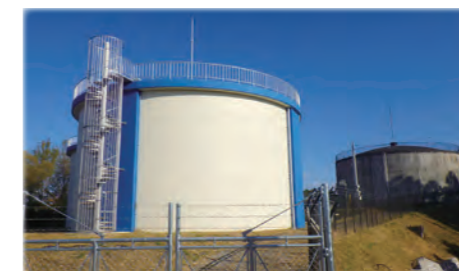
建替えした築館地区薬師山1号配水池
