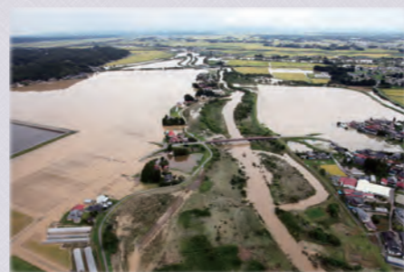
関東・東北豪雨による被害(9月11日)
