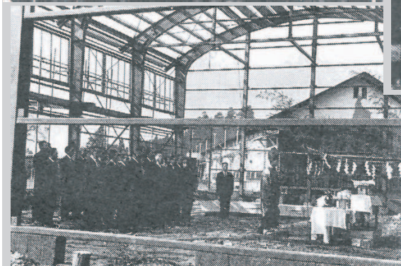
昭和43年 体育館上棟式
