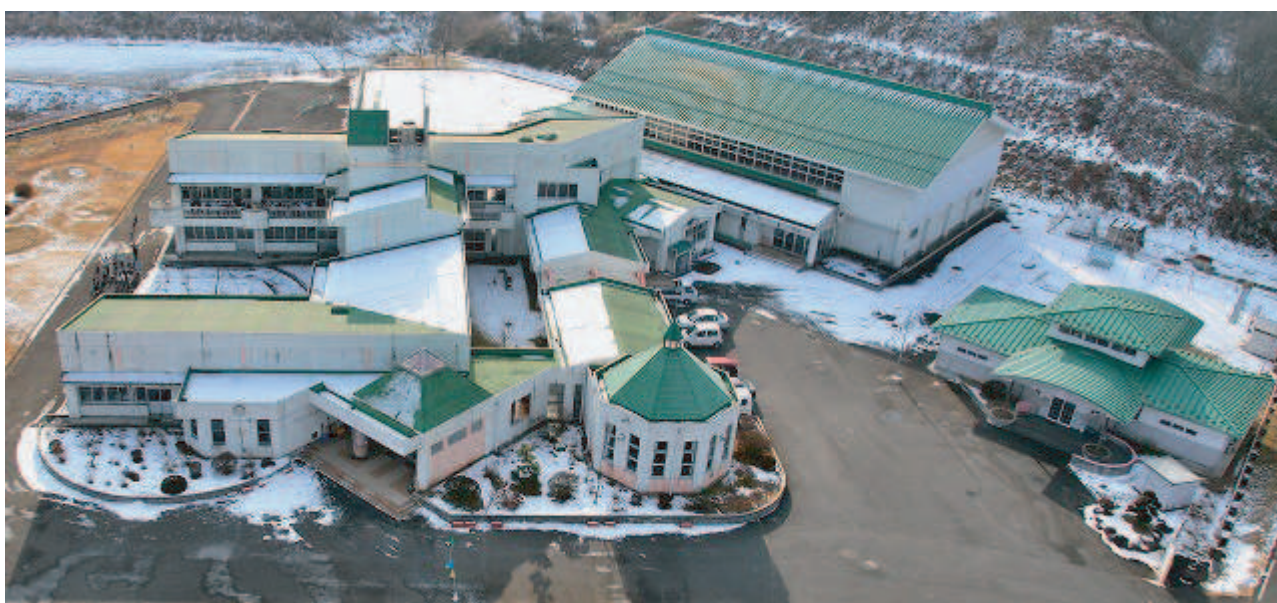
平成24年 校舎上空写真
