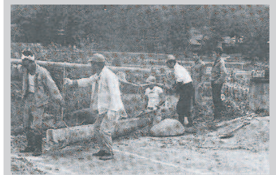
昭和33年 P T A 奉仕作業「側溝工事」
