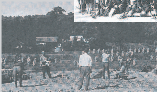
昭和37年 校庭拡張工事
