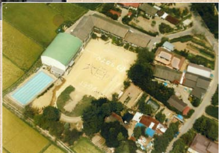
旧校舎航空写真（平成6年）
