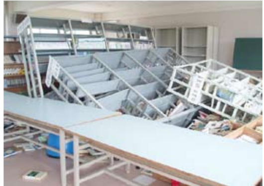
平成20年6月14日 岩手宮城内陸地震図書室の被害
