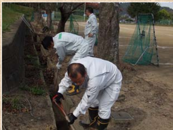
除染作業 (平成 23 年度)
