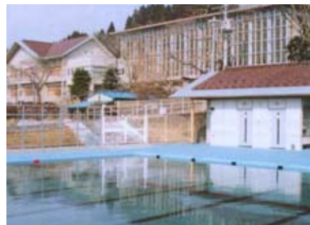
新プール完成（平成15年）
