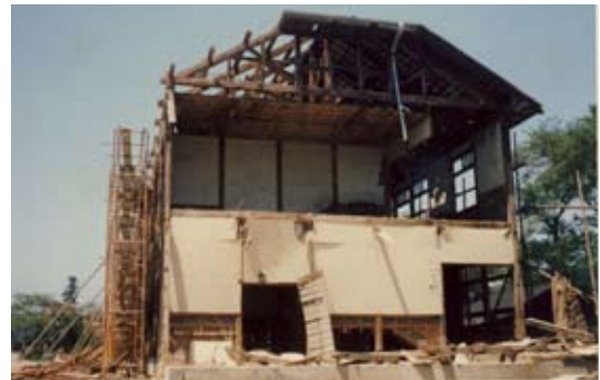
校舎解体工事
