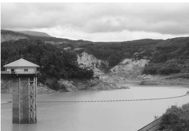
▲土砂が流入した荒砥沢ダム
