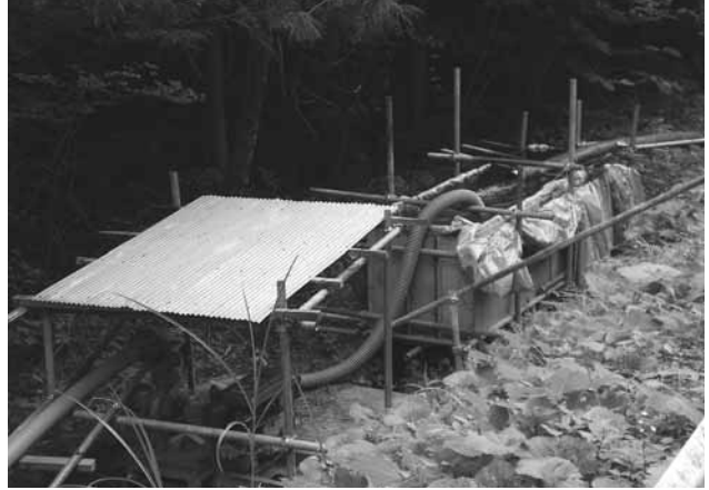
▲ポンプで汲み上げている様子
