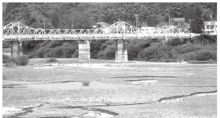
堆積土砂に草が生える花山ダム
