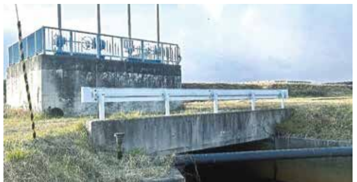
田町川排水機場
