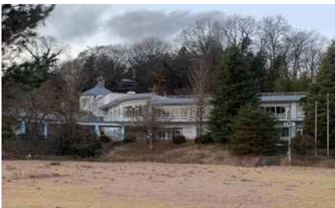
解体される旧畑岡小学校
