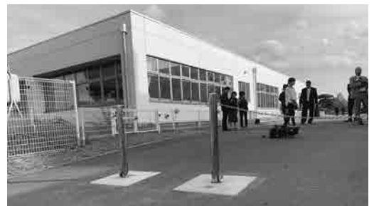
車両進入防止のポール
