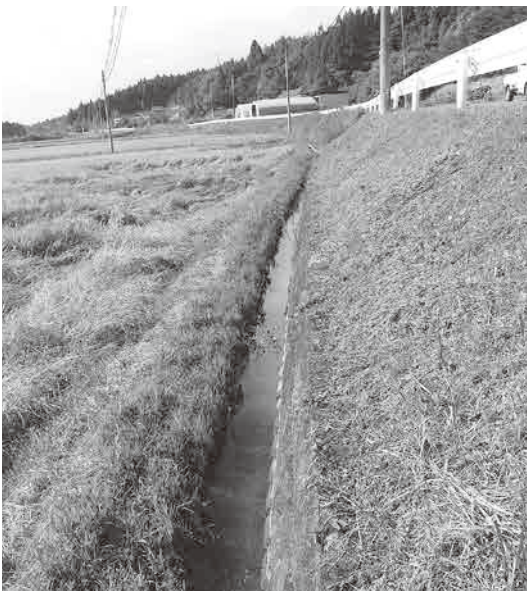
令和7年から整備の有賀沢排水路
