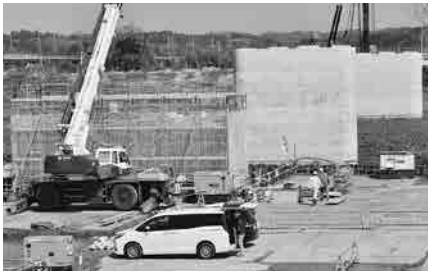
予定どおり進む橋脚工事
