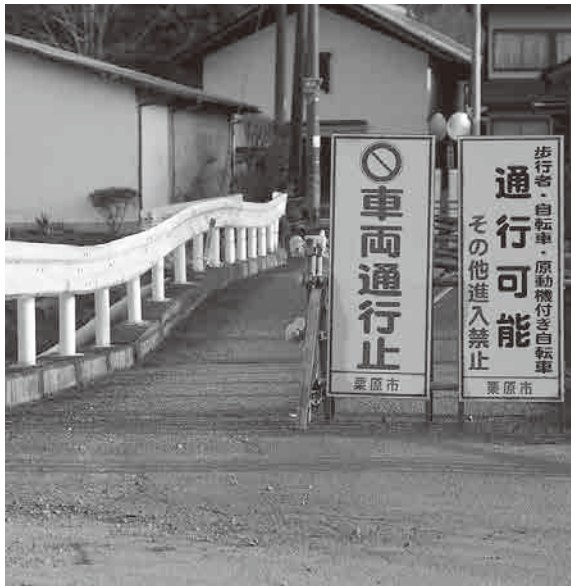
通行止めが続く高橋橋
