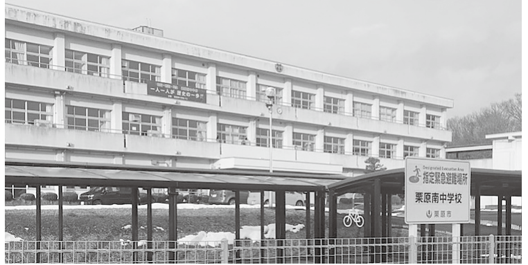
改修工事中の栗原南中学校
