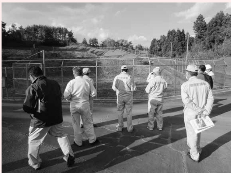
最終処分場の埋め立て状況を調査
