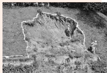
のり面が崩れた築館小学校
