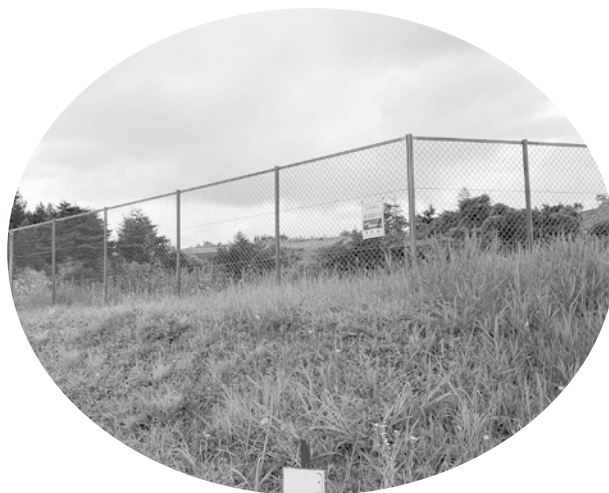
ため池に設置されたネットフェンス
