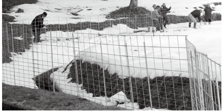
防獣用ワイヤーメッシュの設置作業
