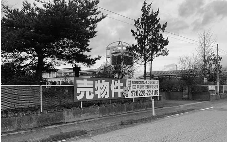
売物件となっている旧大岡小学校用地
