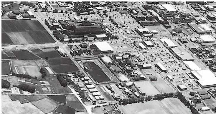
宮野地区栗原中央病院を上空から見る
