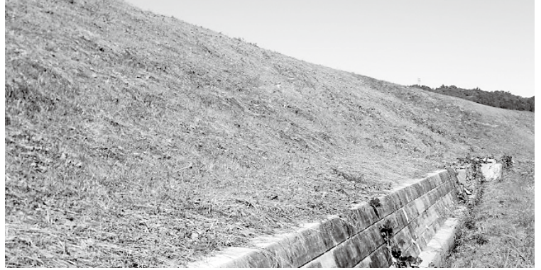
急勾配なため池の堤体
