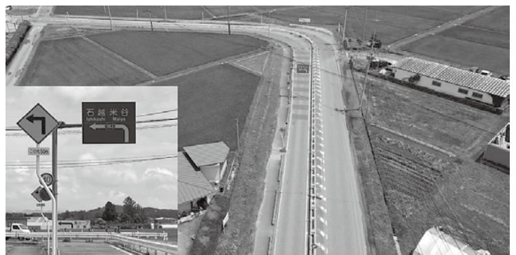
新山十文字線延伸予定の直角カーブ
