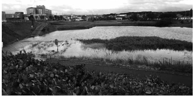
令和元年台風第19号で冠水した公園予定地
