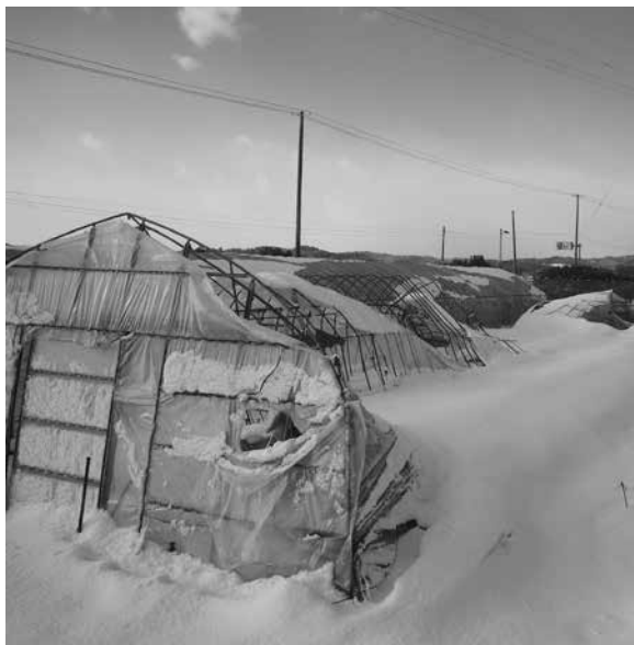
大雪により倒壊したパイプハウス
