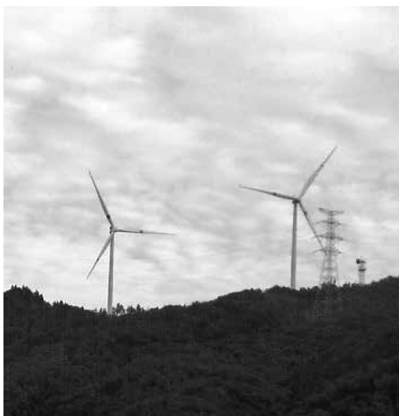
稼働中の風力発電 (石巻)
