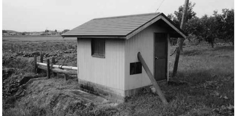
ポンプの更新を待つ揚水機場
