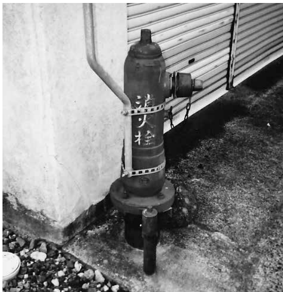
緊急時に活躍する消火栓
