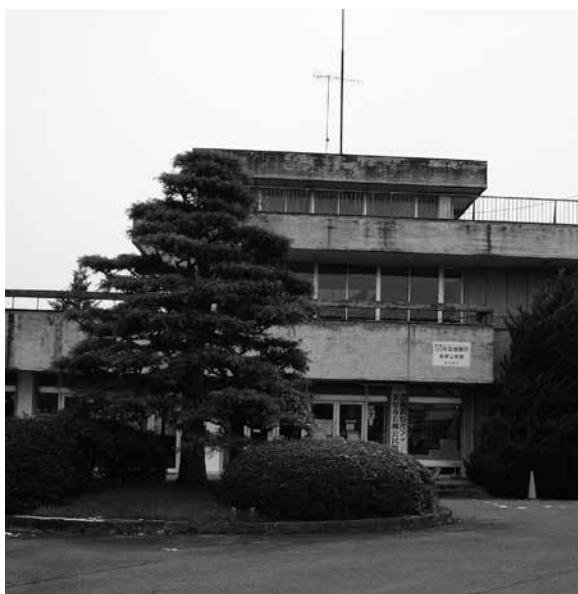
説明不足のまま建設が進む若柳公民館
