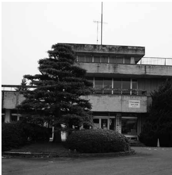
説明不足のまま建設が進む若柳公民館
