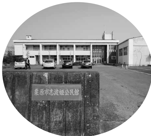
老朽化が進む公民館
