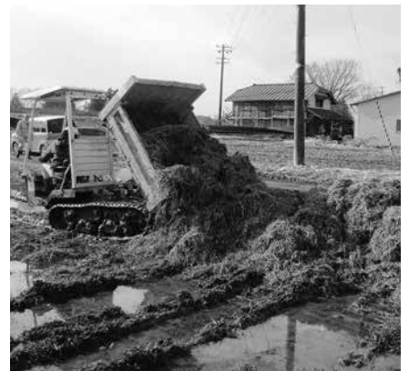
稲わらの撤去作業が進む
