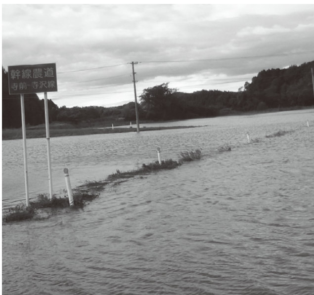
台風19号で完全に水没してしまった農道
