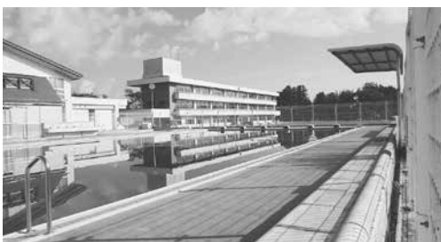
解体される旧玉沢小学校のプール
