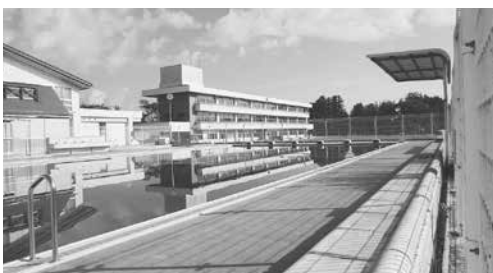
解体される旧玉沢小学校のプール
