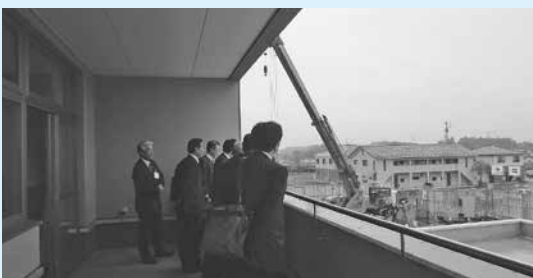
結核病棟の建設現場を視察
