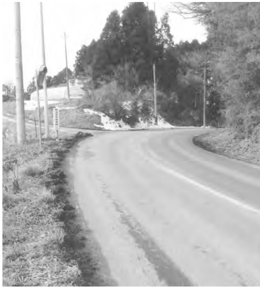
見通しが悪く危険な共葬墓地入口周辺
