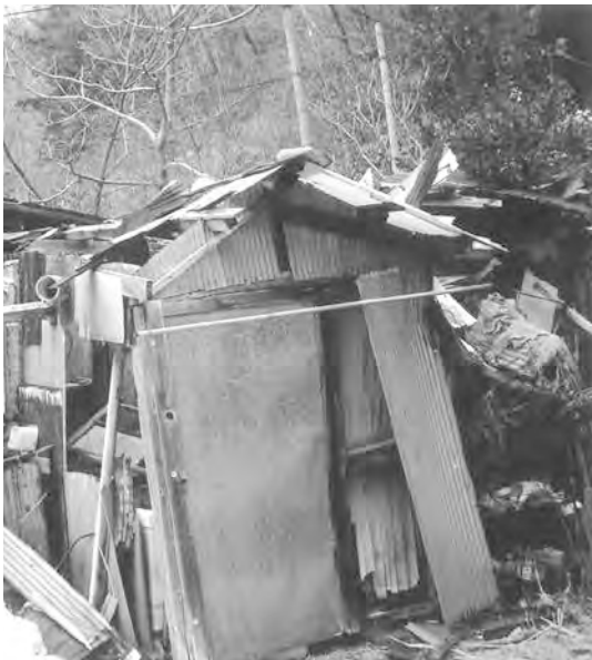
倒壊した空き家
