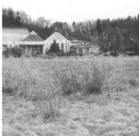
調査中の898カ所公共施設
