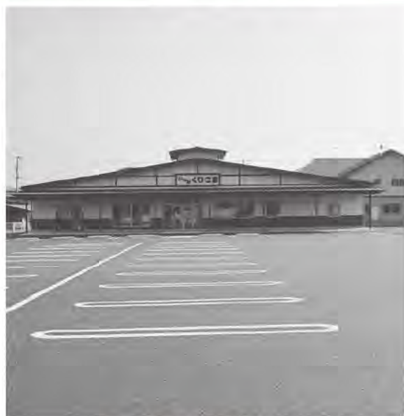
完成した栗駒特産物直売センター
