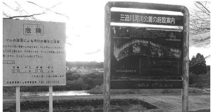
錆びて読み取れない案内板
