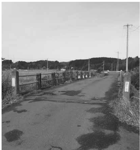
点検業務を行う瀬峰地区樋渡（ひわたし）橋
