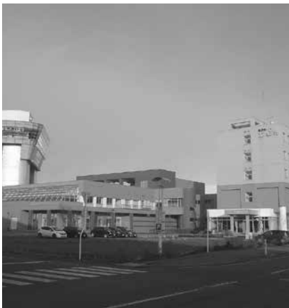
改修予定のくりはら交流プラザ
