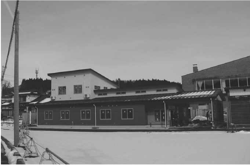
建設中の花山診療所
