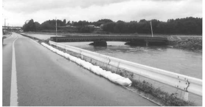
超大型台風21号による荒川の越水
