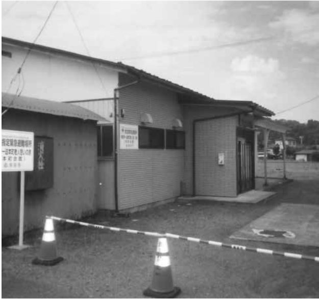
解体が決まった「一迫本町老人憩いの家」
