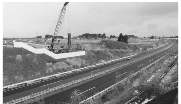
県北道と高速道の接続点
