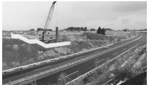
県北道と高速道の接続点
