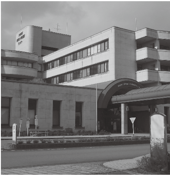
平成31年度移管する瀬峰の県立病院
