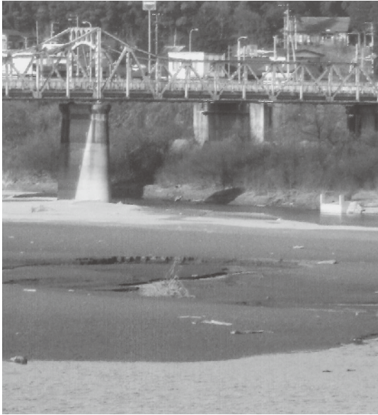
土砂で埋まったダム上流
