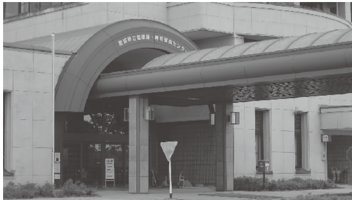
病院が予定されている県立循環器・呼吸器センター
