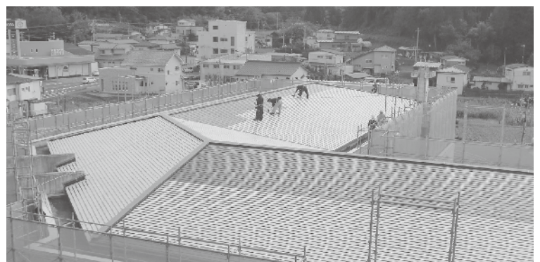
屋根塗装する築館の「ふるさとセンター」
