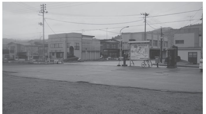
整備が求められる旧栗駒駅構内
