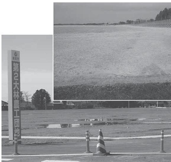
完成した工業団地
