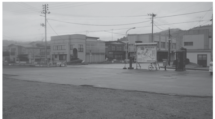
整備が求められる旧栗駒駅構内
