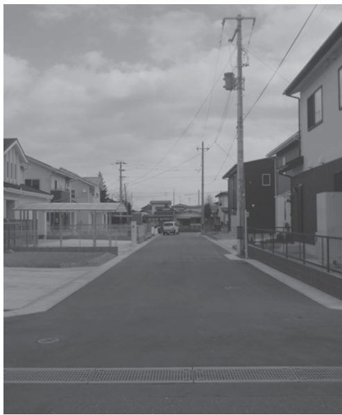
建設が進む宅地分譲地
