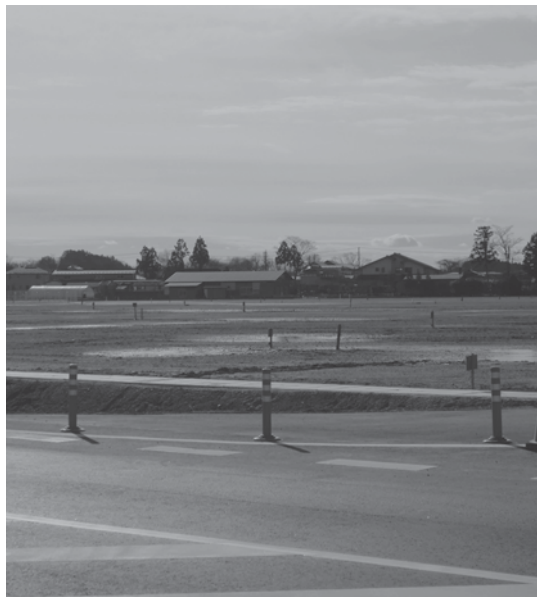
完成間近な第2大林農工団地
