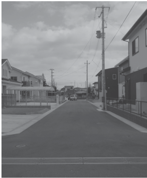
建設が進む宅地分譲地
