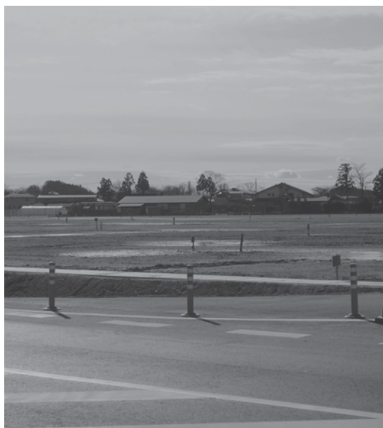
完成間近な第2大林農工団地
