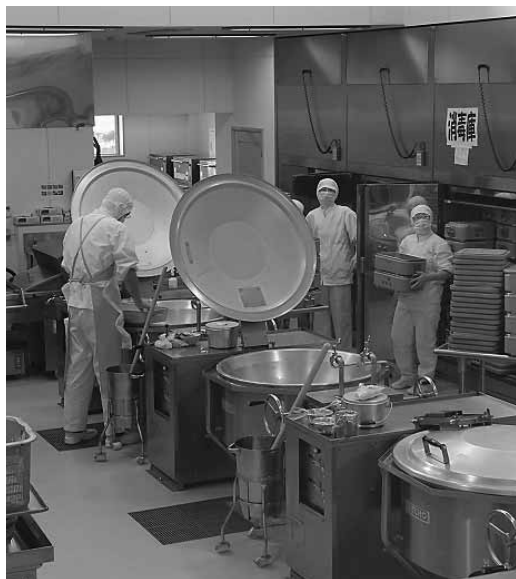
炊飯設備がある一迫の給食センター
